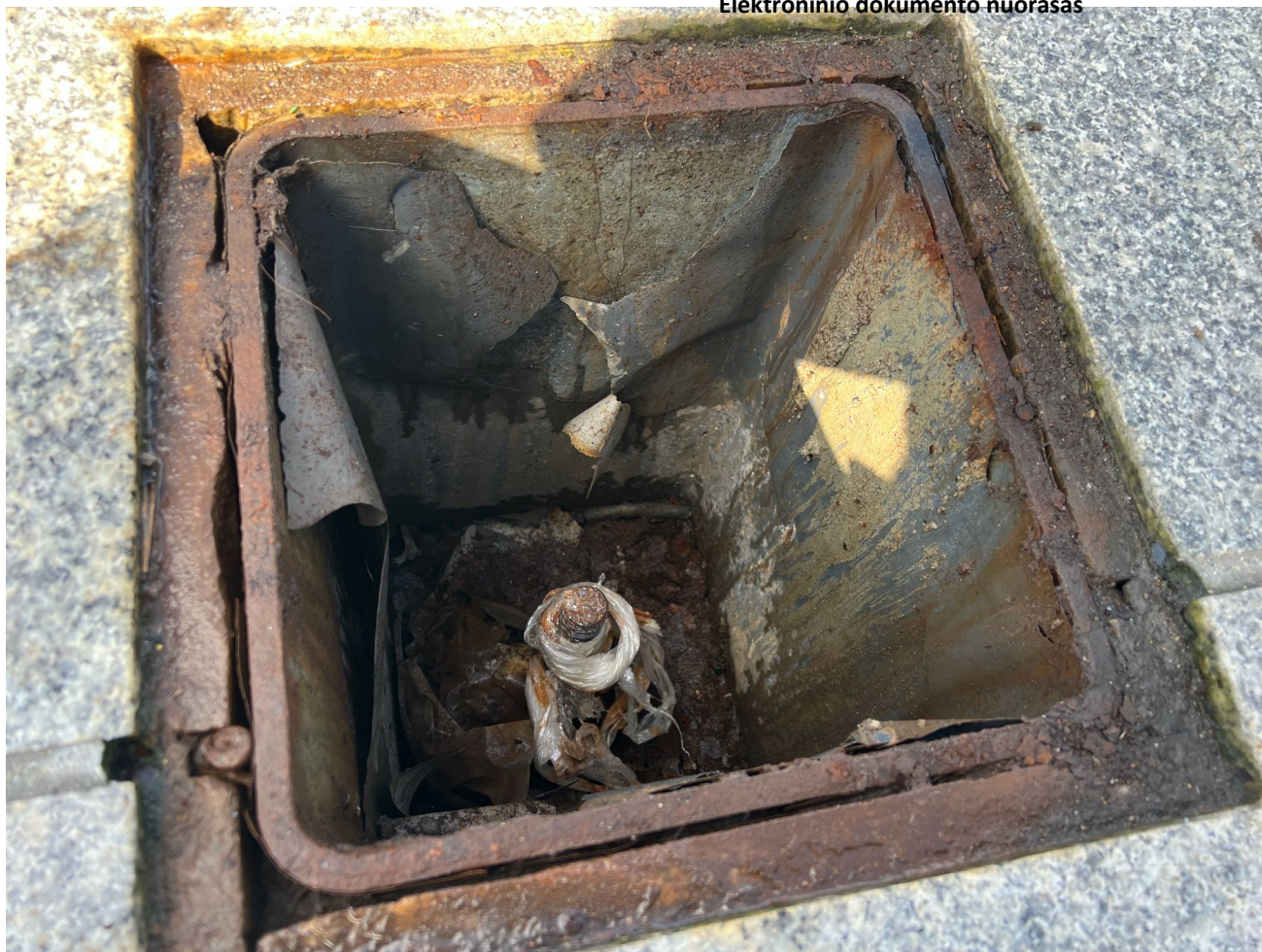
Inkaravimo varžtas eglutės stovo tvirtinimui
